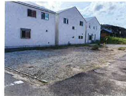
【北東角にある電柱】
